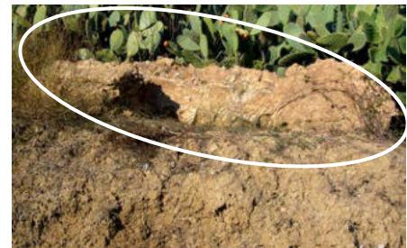
Fig. 4. 19 : Vue sur 03 segments détachés après les terrassements propriété Khoudir Source : Auteurs
