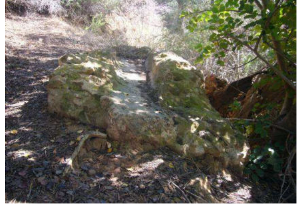
Fig. 4.1 : vestige de l'aqueduc en milieu rural sur un sentier
