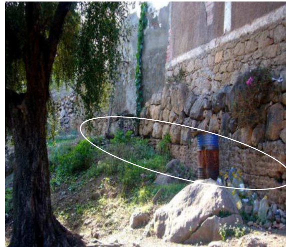
Fig. 4.6 : Vestiges de l'aqueduc servant de soubassement de construction (Boumoula)
