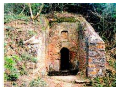
Fig. 2.22: Vue sur entrée aqueduc tunnel de Toudja
