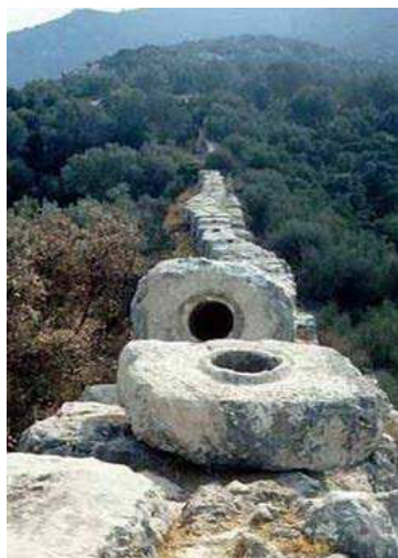
Fig2. 24 b : canalisation En pierres percées.
