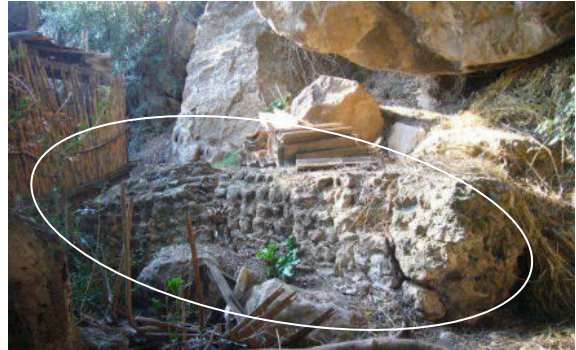
Fig. 4. 3 : Vue sur un segment fragmenté par les chutes de rochers à Thimriouine
