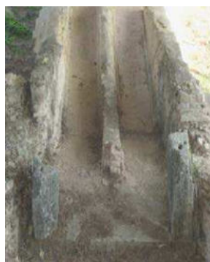
Fig. 2.17 : Aqueduc semi enterré à double conduites de Saint Fontaine.
