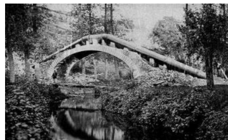
Fig2.24.a : schéma d'un pont-siphon.
