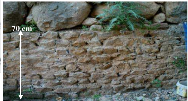
Fig 4. 33 : Détails point 7 cunette, blocage et blocage des points 8 et 9 (soubassement)
