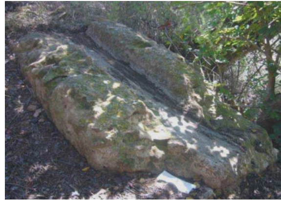
Fig 4. 46: Un segment d'aqueduc (Pt 24) au contrebas De Tighilt Nath Zaien, sur le sentier Source : Auteurs
