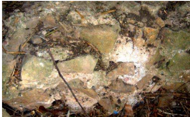
Fig 4.48 : vue sur l'opus caementicium (pierres, sable, chaux avec tuileaux)
