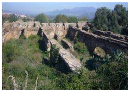
Fig.3.8.b : Vues sur les citernes d'El Ariouia après lancement PPMVSA, 2013 Source : Auteurs
