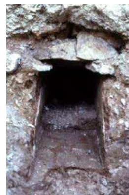
Fig. 2.18 : Vue sur conduit de l'aqueduc souterrain de Villedieu sur Indre –France Source : G. Coulon.
