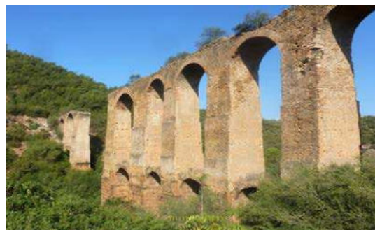
Fig. 2.21: Vue sur l'Aqueduc de Cherchell. Source : http://www.panor-amio.com .
