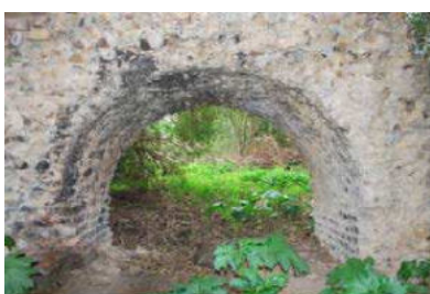
Photo. 3.2 d: Porte en arc en bon état de conservation
